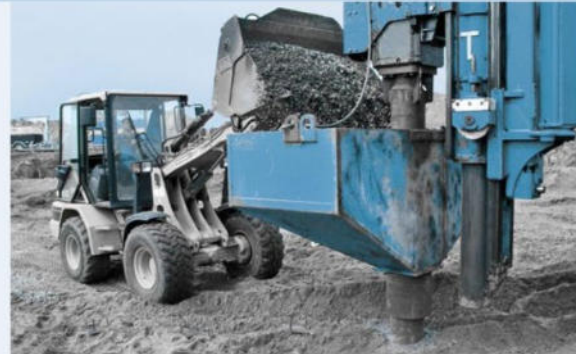
Abbildung 12: Darstellung des Impact - Herstellungsverfahrens
